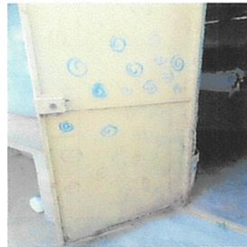
Foto 4: Reparación de puerta de la cocina.
