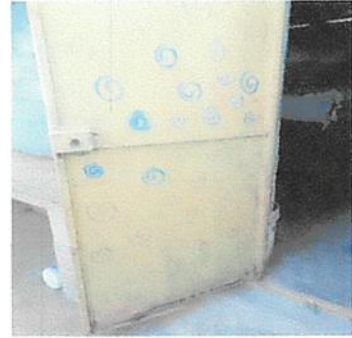
Foto 6: DETERIORO DE PAREDES Y PUERTAS DE COCINA
