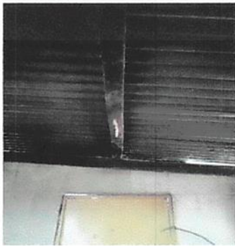
Foto 3: Sustitución del techo de la cocina.
